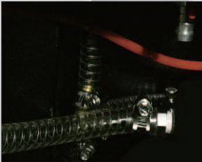
高圧ホースを使用
